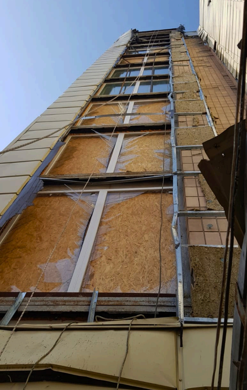
Archivgebäude nach einem Drohnenangriff im März 2025. Standort und Name der Institution werden aus Sicherheitsgründen nicht genannt.
